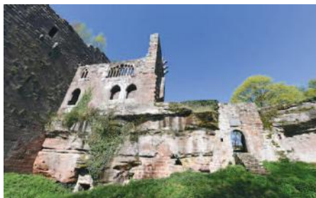
La Wasenbourg pour ses détails architecturaux. PHOTO DNA - F.K.
