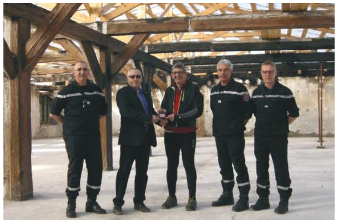
Didier Reneaux à eu droit à une petite visite du chantier du futur centre de secours de Lauterbourg. PHOTO DNA
