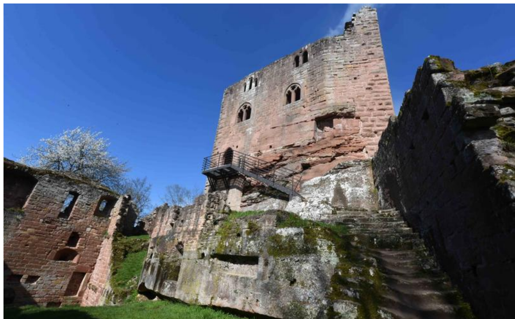
Le Nouveau-Windstein a été construit entre 1200 et 1250 puis agrandi en 1339 après la destruction du Vieux-Windstein, situé sur un rocher voisin. Il est composé d'un impressionnant mur bouclier de 22 mètres de haut auquel est adossé le palais. PHOTOS DNA - FRANCK KOBİ
