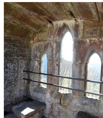
Une passerelle permet désormais d'accéder à la basse-cour, dans l'enceinte du château fort (à gauche). Une fois qu'on est entré dans le logis, un escalier et une coursive mènent aux étages supérieurs (au centre) où les fenêtres à meneaux ont été sécurisées par la mise en place de barreaux (à droite).
