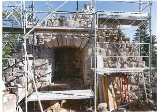
Fig. 15B Château de Kagenfels - La niche d'archère est du logis remontée (Photo Mathias Heissler)
