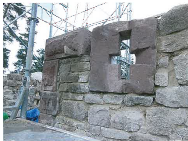
Fig. 16 Château de Kagenfels - Meurtrière MA en cours de remontage (Photo Mathias Heissler)
