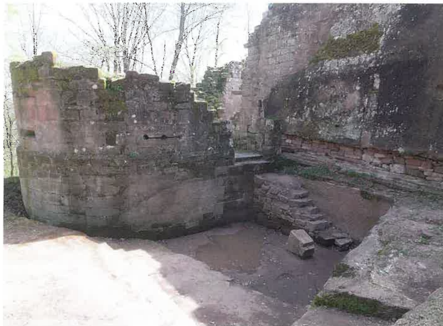
Fig. 20 Château de Nouveau-Windstein - Base de la barbacane mise au jour en 2014 (Photo Alain Kieber)
