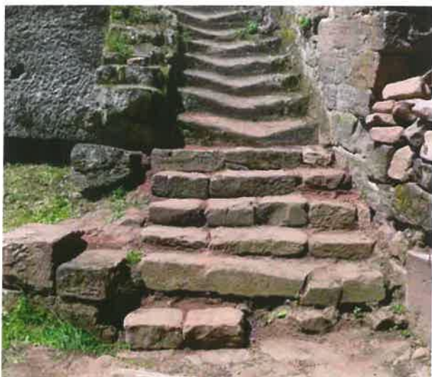
Fig. 16 Nouveau-Windstein - Escalier menant à la partie haute du château après dégagement (Photo Alain Kieber)
