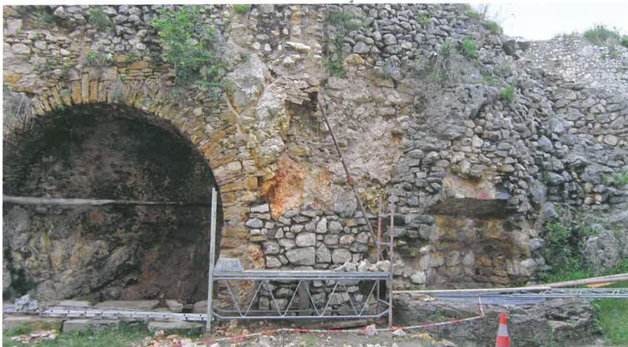
Fig. 14 Landskron – Réalisation de travaux de consolidation (Photo Jürg Tischhauser)
