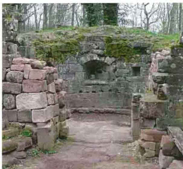
Fig. 15 Nouveau-Windstein - Le dallage et le ressaut intérieur après dégagement (Photo Alain Kieber)
