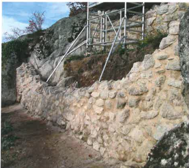
Fig. 17 Ramstein - Mur de fausse-braie Sud après consolidation (Photo Rémy Frey)
