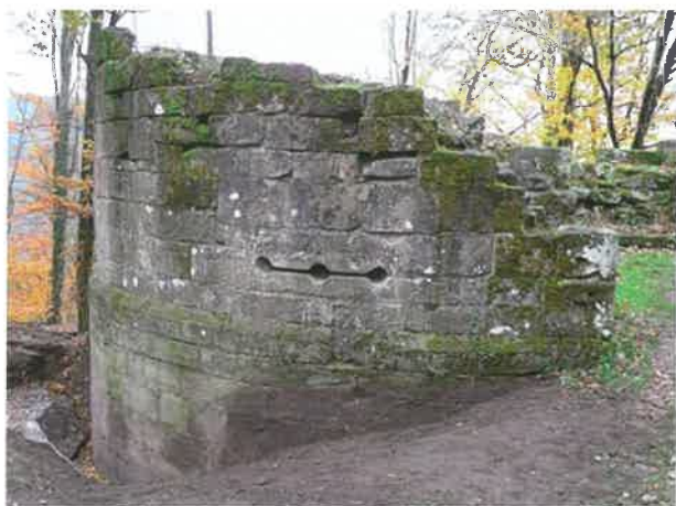
Fig. 13 et 14 Château de Nouveau-Windstein - Le bastion circulaire avant et après le sondage (Photo Alain Kieber)
